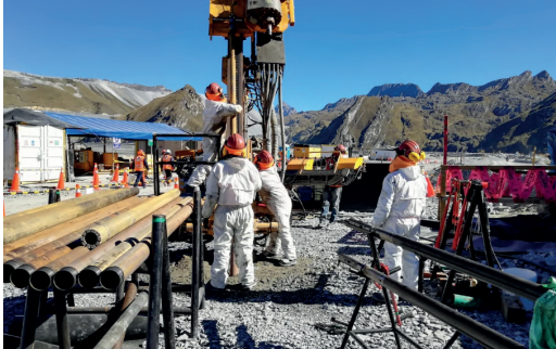
Pantalla de Impermeabilización Blanket Estribo Derecho 4,135 msnm Ubicación: Áncash Cia. Minera Antamina
