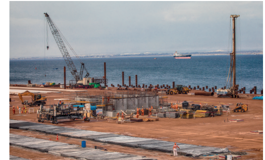
Obras Civiles Terminal Portuario Paracas (Puerto General San Martín) Ubicación: Ica Terminal Portuario Paracas
