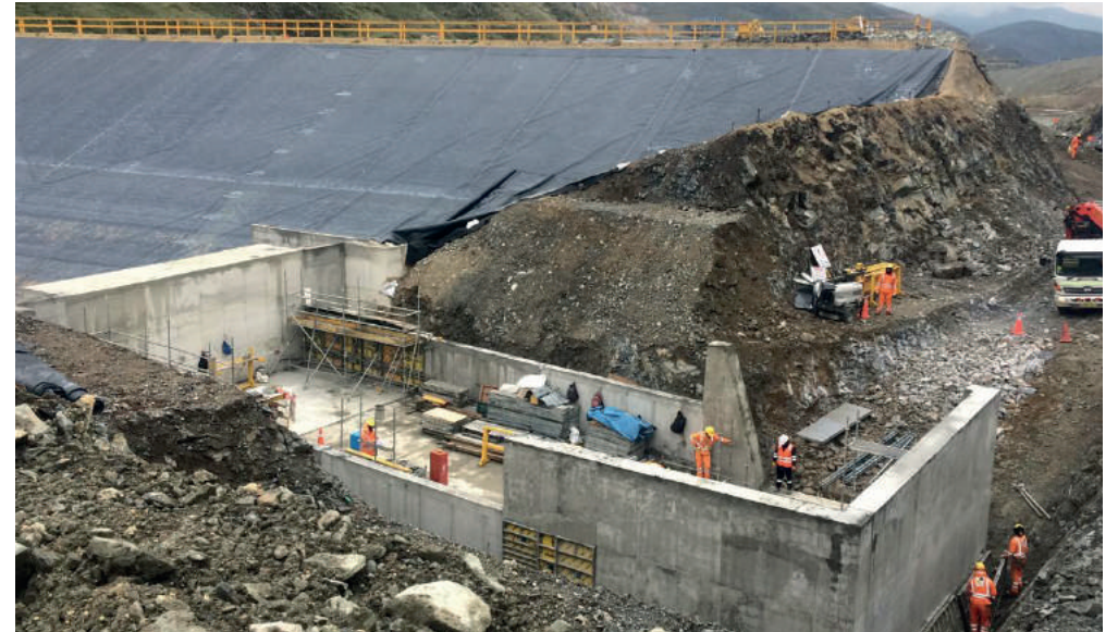
Construcción del Aliviadero de Emergencia de la Presa de Sedimentación y Canal de Derivación T-5
