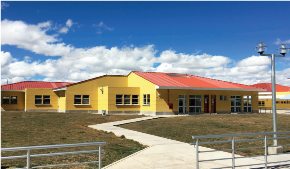
Diseño y Construcción del Hospital de Apoyo San Martín de Porres de Macusani
