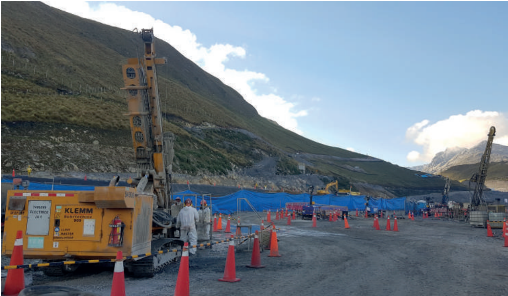
Pantalla de Impermeabilización Blanket Estribo Derecho 4,135 msnm
