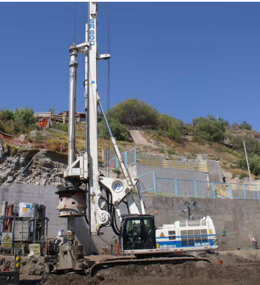
Pilotaje en Puente Chilina, Arequipa Piling in Chilina Bridge, Arequipa
